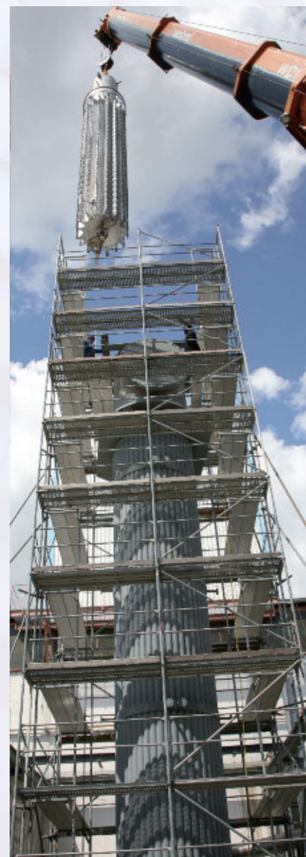
Монтаж сушильного аппарата CP
